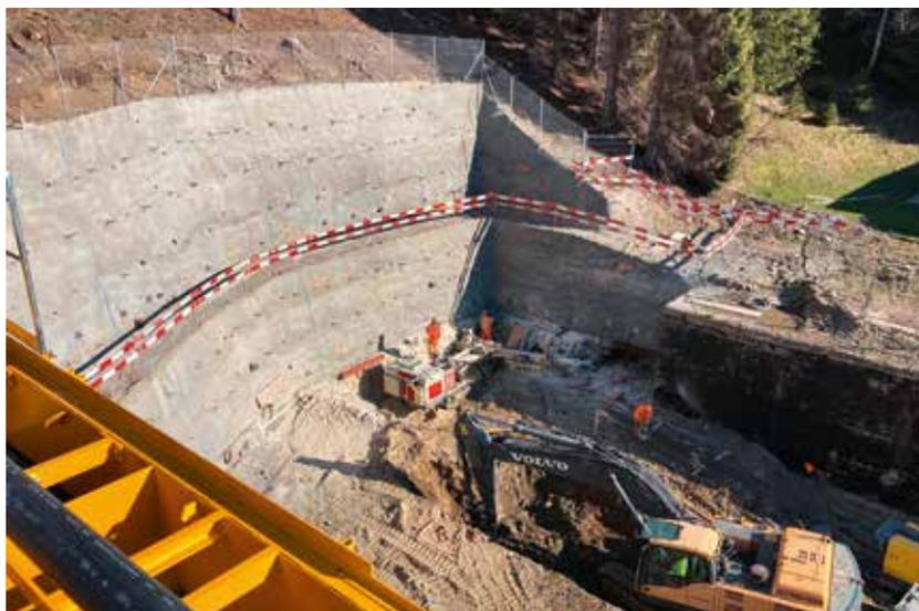
Nell'ambito della costruzione del raddoppio della galleria autostradale del San Gottardo di è reso necessario lo spostamento di circa 300 m del cunicolo di sicurezza attualmente in esercizio. Questo cantiere si compone di una parte di lavori in sotterraneo (scavo del cunicolo e della caverna di innesto con l'opera esistente) e di una parte di lavori all'esterno (scavo per la trincea di approccio e nuova centrale di ventilazione).
